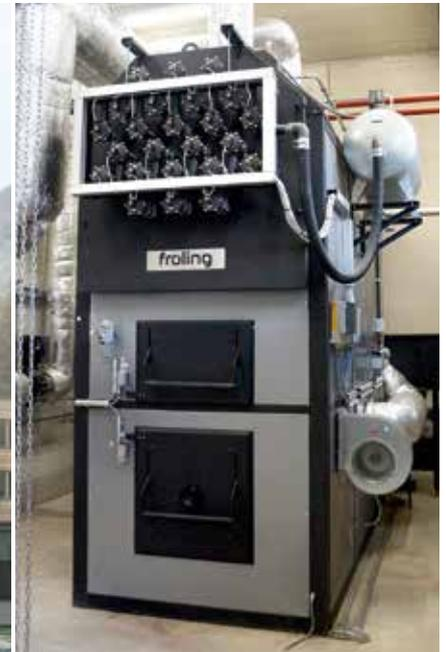
Im \*\*\*\* Superior Hotel Gradonna Mountain Resort in Kals am Großglockner sorgt eine Fröling Kaskaden-Anlage für wohlige Wärme aus Holz. Vorgabe war ein Lösung die in der Lage ist unterschiedlichste Brennstoffqualitäten (von trocken bis nass, von klein bis groß) möglichst effizient und betriebssicher zu verarbeiten. Zur bestmöglichen Abgasreinigung wurden Gewebefilter und zur Steigerung der Energieeffizienz eine Kondensationsanlage integriert.
